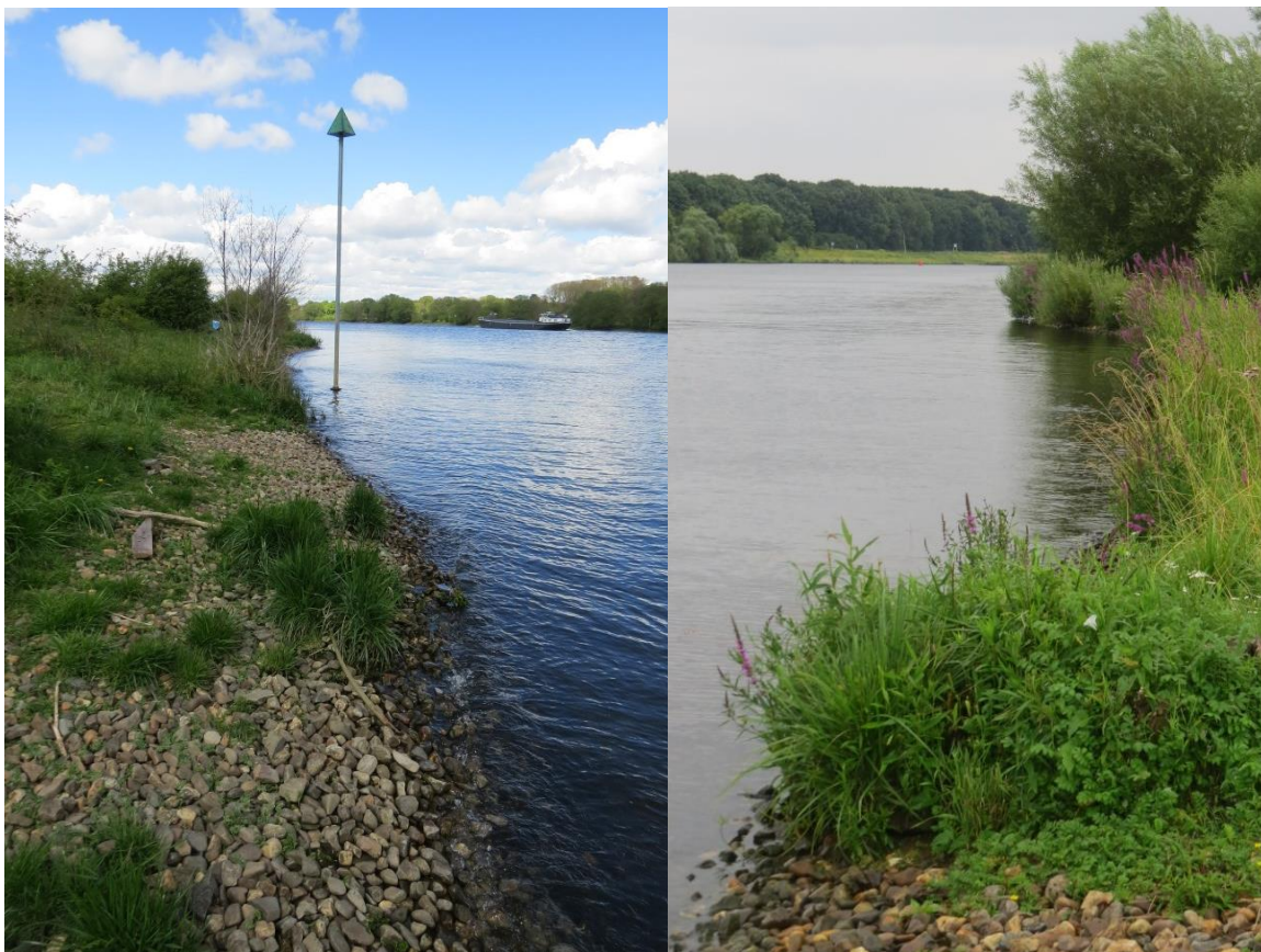
Figuur 3.22 Grof Maasgrind beschermt de oever en verhindert verdere erosie
