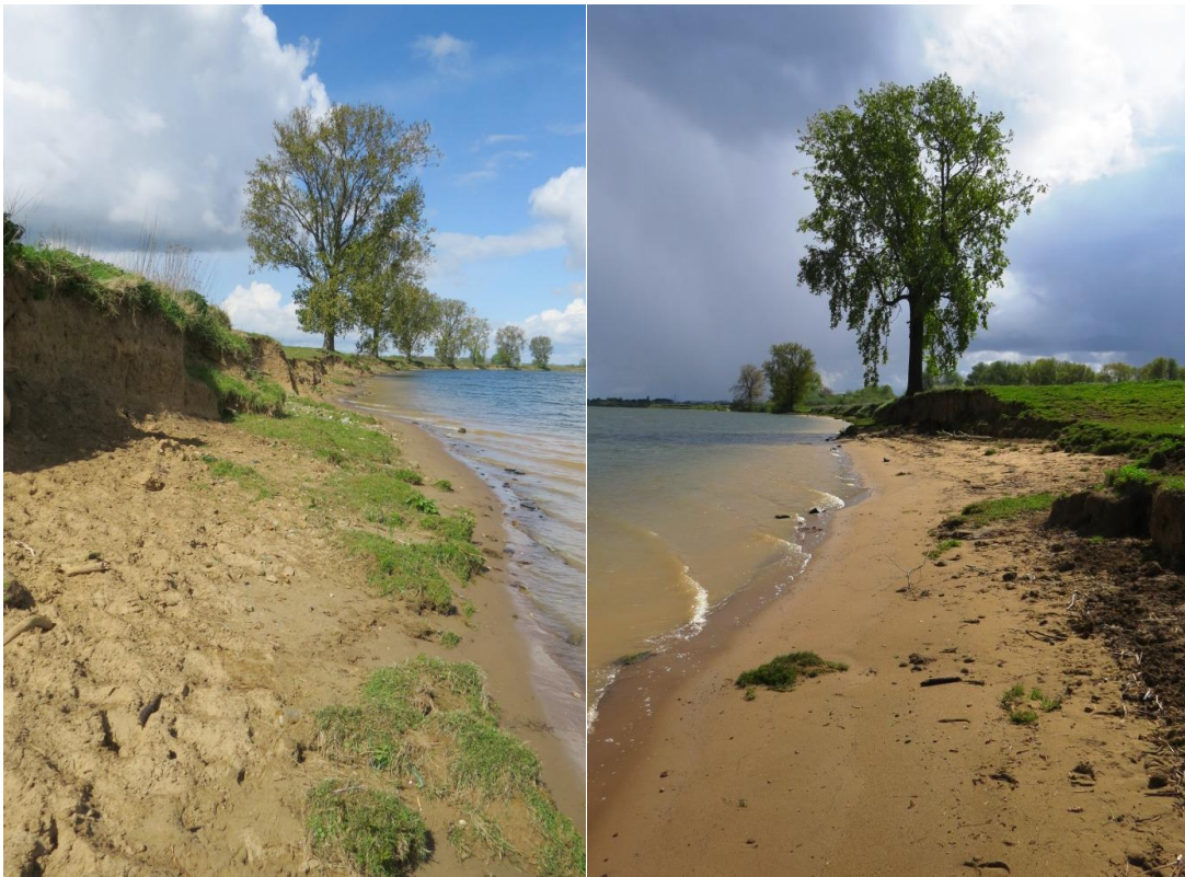
Figuur 3.60 Ontwikkeling van steiloevers en zandstrand in de hoofdgeul na verwijdering van de steenbezetting
