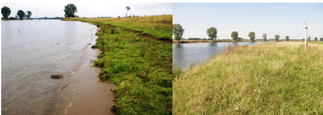
Figuur 3.63 Zandstrand en lage steiloevers (links); kruidenrijke vegetatie op de droge oevers (rechts).
