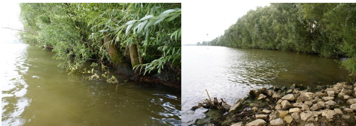
Figuur 3.31 Wilgenbomen op het talud zijn gehandhaafd om de Maasoever te verstevigen en de leefomgeving van de das te behouden.
