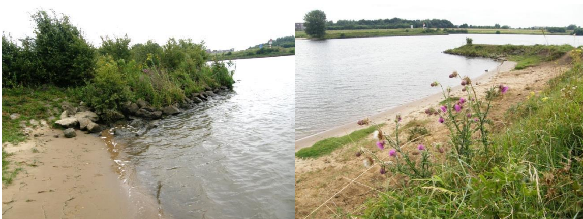
Figuur 3.102 Kribben zijn verstevigd met stortsteen. Tussen de kribben zijn de stortstenen verwijderd.
