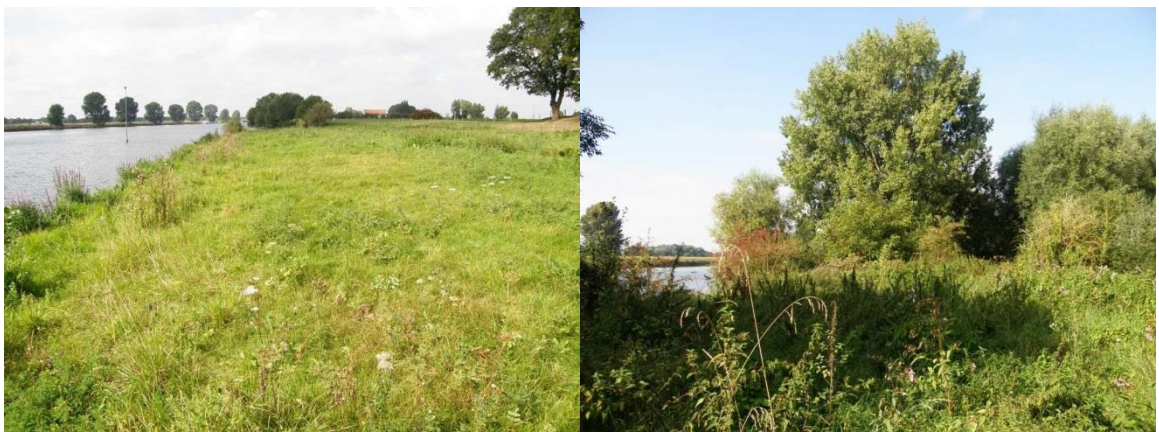
Figuur 3.40 Stortstenen oever westelijk deel Gebrande Kamp (links) en verruiging ten zuiden van de baai (rechts)
