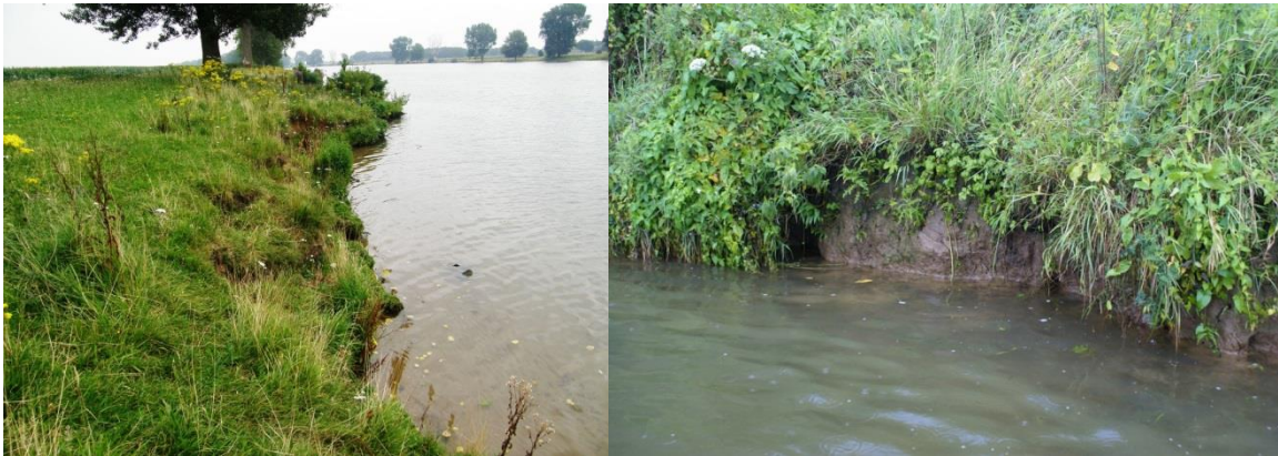
Figuur 3.51 Coehoorn 2: Begroeiing en kleilig materiaal vertragen de erosie.
