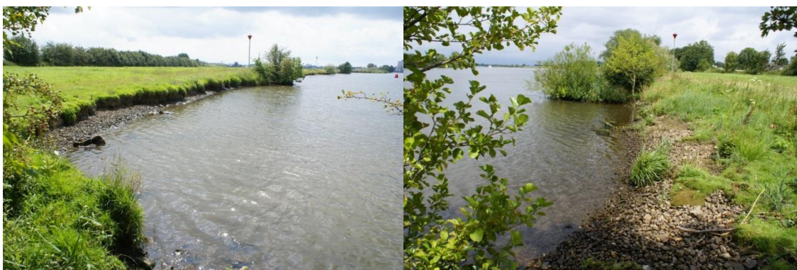
Figuur 3.11 Grind vertraagt de oevererosie bij Aijen. De steilwanden zijn laag en de oevers soortenarm en deels verruigd
