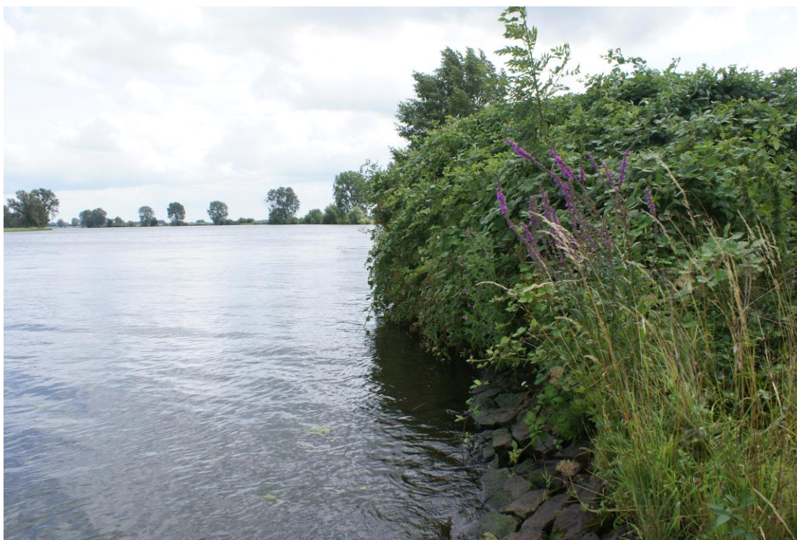
Figuur 3.60 Steenbekleding (2015)
