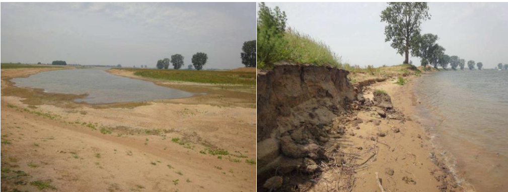
Figuur 3.48 Nieuwe hoogwatergeul (links). Verlaagde zandige drempel van de hoogwatergeul (rechts) (2013)
