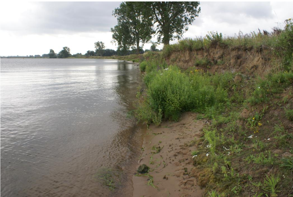
Figuur 3.49 Keentse oever in de hoofdgeul na verwijdering van de steenbezetting (2015)
