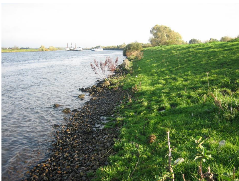
Figuur 3.2. Stortstenenoever van de Asseltse plassen (foto Frans Kerkum).
