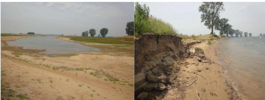
Figuur 3.36 (Links) Nieuwe hoogwatergeul. (Rechts) Verlaagde zandige drempel van de hoogwatergeul (foto Bart Peters).
