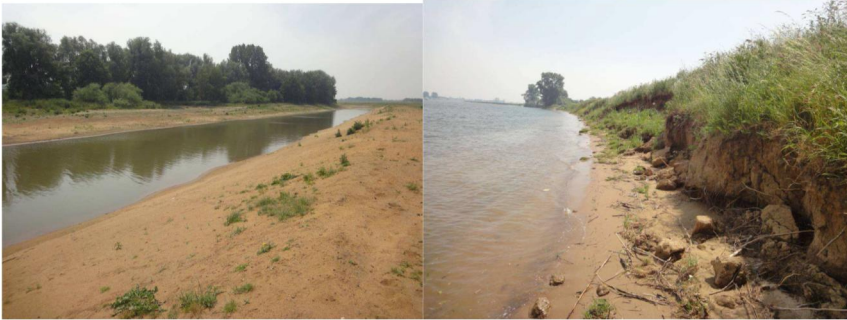
Figuur 3.35 (Links) De nieuw gegraven parallelgeul langs het oobosje. (Rechts) Vrij eroderende oever met een ontwikkelende zandige rivieroever (foto Bart Peters).
