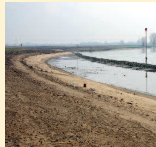
Foto 2. Recent aangelegde natuurvriendelijke oever(plasberm) langs de Maas bij Heerewaarden, met golfbrekende vooroever van breuksteen (foto: Bert Overkamp, 2012).
